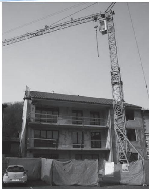
Le bâtiment est « hors d'eau, hors d'air » : charpente et toiture posées, menuiseries extérieures et intérieures installées, doublage et étanchéité terminés, dalles de finition coulées. Les travaux en cours portent sur l'électricité, les peintures, les revêtements de sol et l'aménagement de la boulangerie-multi-services.
